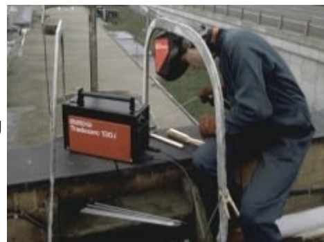
Figuur 1: Moderne stroombron met thyristor regeling
